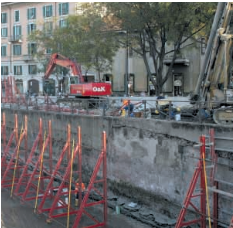
▲ La posa dei micropali forniti da TenarisDalmine nel cantiere di via Valenza, nel tratto iniziale del Naviglio Grande milanese.
