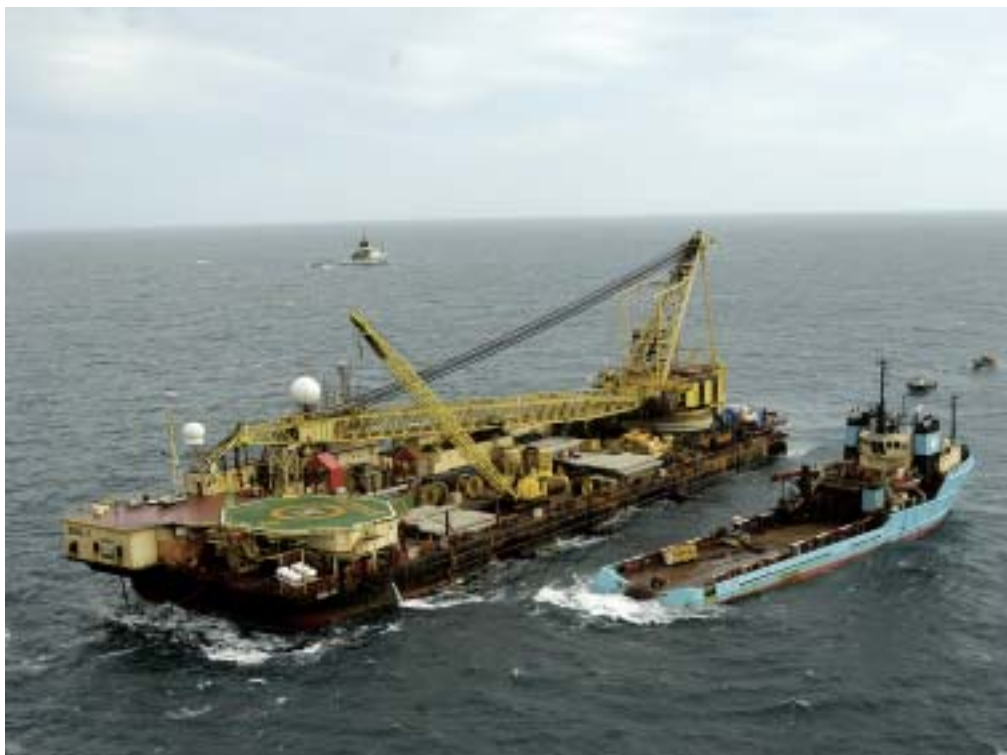
▲ Lançamento dos tubos fornecidos pela TenarisConfab para transportar gás dos campos de Congoá e Peroá até a estação de tratamento, em Linhares (ES).
