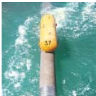
◀ O flutuador mantém o alinhamento dos tubos durante o lançamento.
