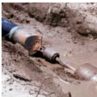
▶ O tubo é preparado para a instalação sob o rio pelo sistema de perfuração dirigida.
