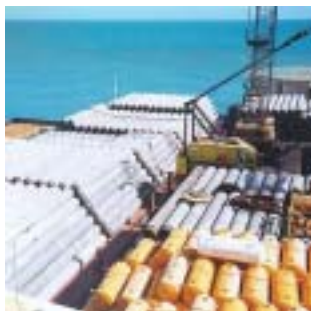
◀ Os tubos ficam armazenados no navio enquanto aguardam a montagem e o lançamento
