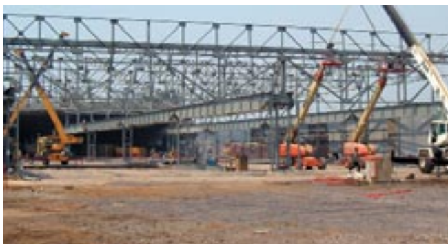
▲ Trabajos de la ampliación de la planta de tubería estirada en frío de TenarisTamsa.
