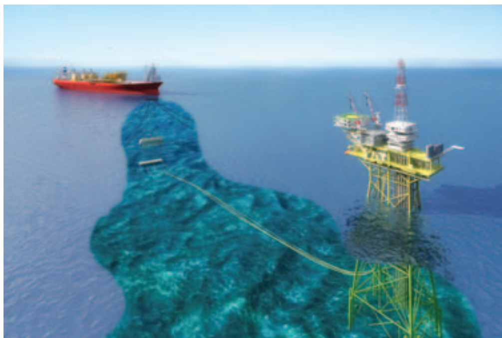
▲ A produção será pelo sistema de completção seca, composto de uma plataforma fixa e um FPSO.
