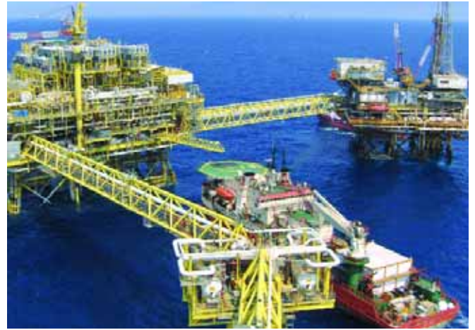
▲ Gran parte de la estructura de la plataforma PB-KU-A2 está sostenida por tubos de TenarisTamsa.
