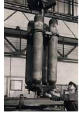
Trattamento termico Anni - 40-50
