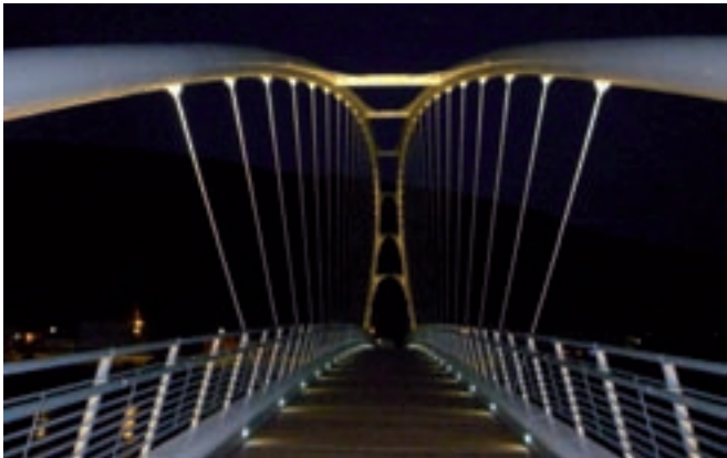
Ponte S. Michele all'Adige, Trento, Italy Tubular arch structure support
